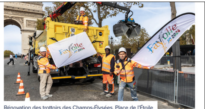
Rénovation des trottoirs des Champs-Élysées, Place de l'Étoile
