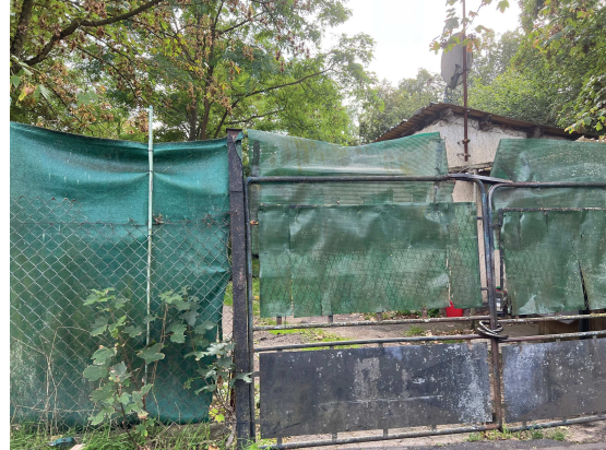
Figure 6 : Barrières mal entretenues
