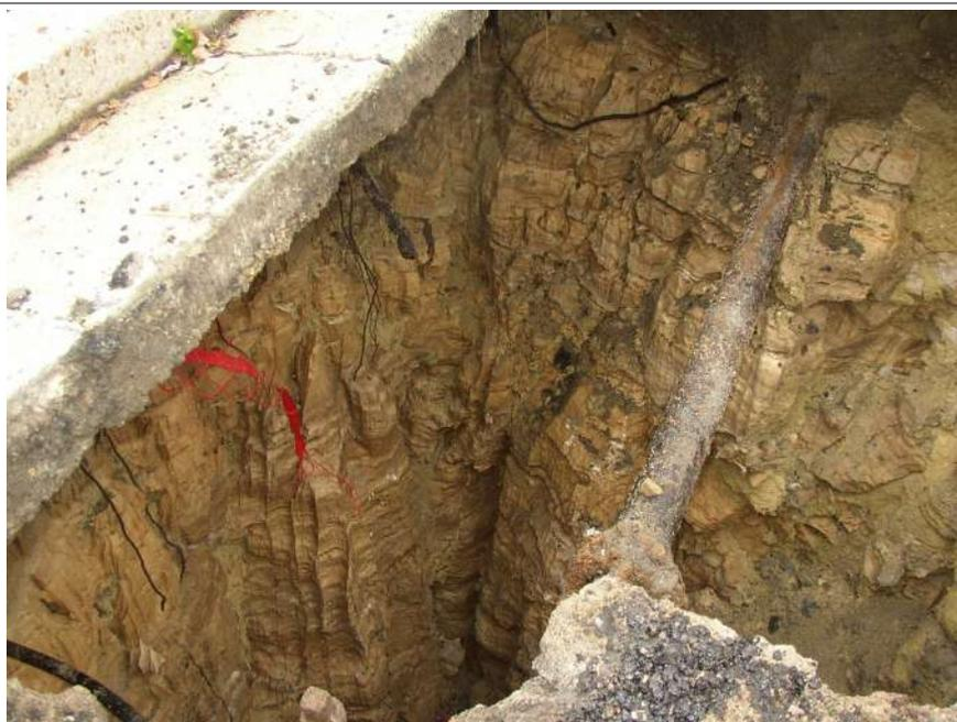
*Photo 6 - Exemple d'effondrement de chaussée suite à des fuites du réseau d'assainissement – Commune de Villeteuse, butte de Montmorency (photographie source CEREMA)*
